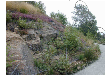
Esempi di opere attive applicano forze puntuali → legature e chiodature applicano forze superficiali → reti e chiodature
